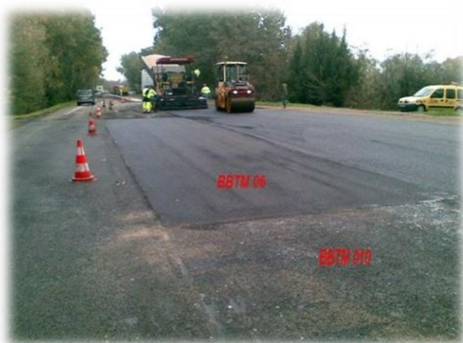
Travaux de réfection RD570, ©D. Quekenborn (GCP) novembre 2012
